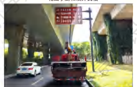
至喜大桥下,下桥后掉头处前
